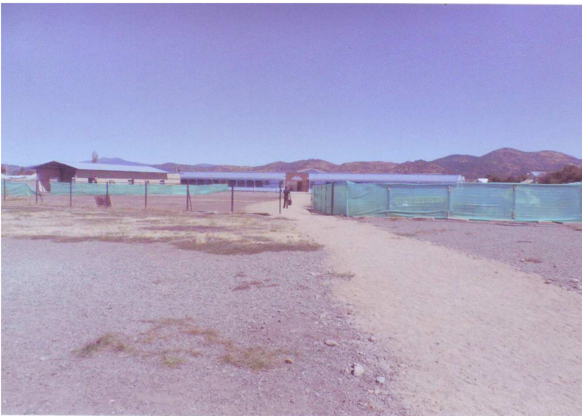
ESPACIO ENTRE EL PABELLÓN DE BÁSICA Y EL PABELLÓN DE MEDIO
